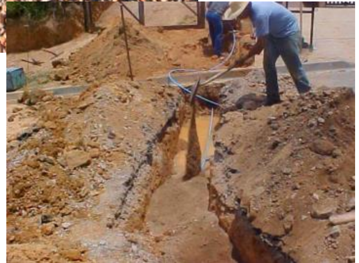
Fechamento de vala para tubulação de água – Campinas – SP (VEDRONI, 2007)
